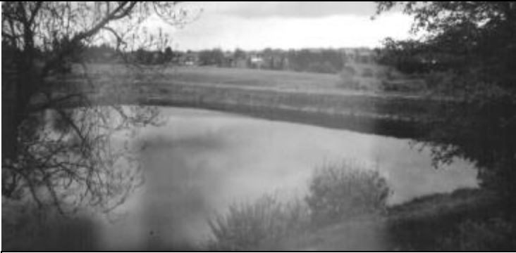
Oberar Eschenbacher Teich, Zellerfeld. One of some 60 waterbodies created to assist in mining operations near Clausthal-Zellerfeld. Oberar Eschenbacher Teich, Zellerfeld. Ein von einigem 60 Seen hat geschaffen, beim Bergbau Betriebe nah Clausthal-Zellerfeld zu helfen.
