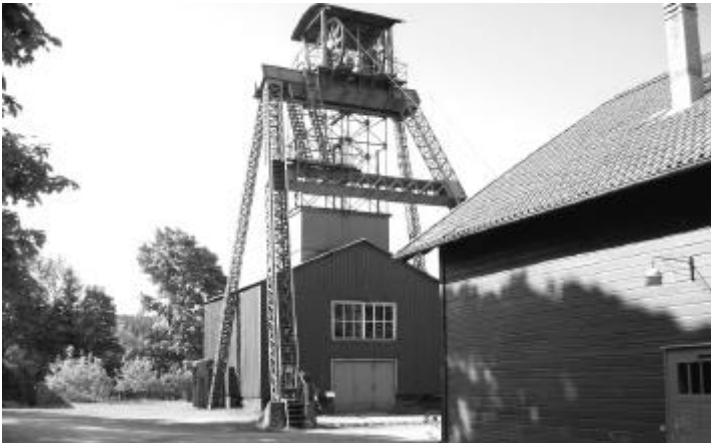
Ottiliae Schacht. Oldest preserved winding gear of iron construction in Germany (1876). Above ground mine railway runs in summer on weekends. Über Boden minieren Sie Eisenbahn läuft in Sommer auf Wochenenden.
